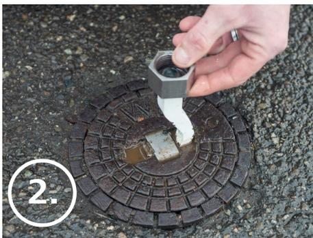
Den Haken in den Ziehsteg einsetzen. Gegebenenfalls mit dem Hammer nachhelfen. Das geschlossene Ende des Hakens zeigt dabei in Richtung Kappensicherung.
